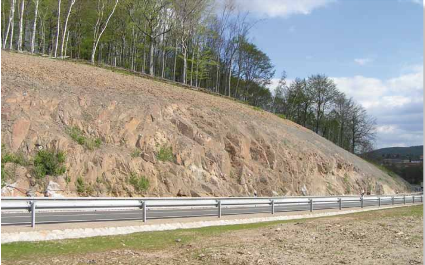
Confortement d'une paroi rocheuse à l'aide de filets de protection. Nouvelle bretelle d'autoroute
