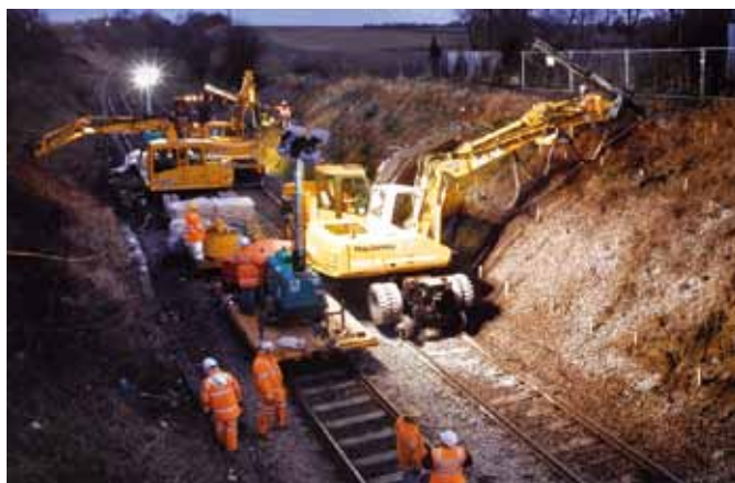
Confortement de talus sur les deux pentes longeant une voie de chemin de fer en Grande Bretagne
