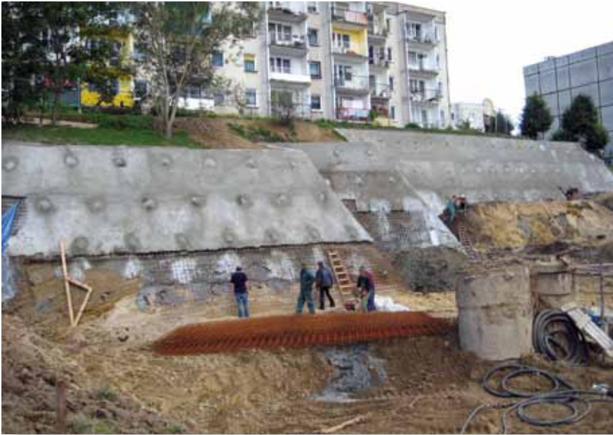
Confortement d'une fouille à Polchin Zdroj, Pologne
