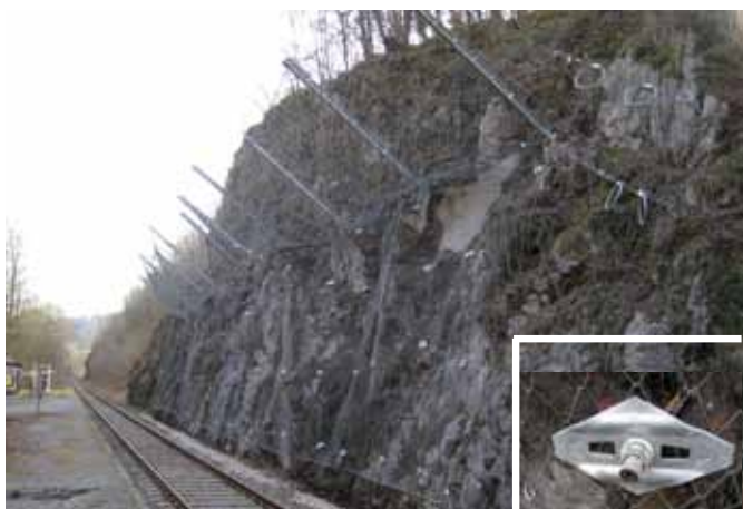
Confortement de talus sur les deux pentes longeant une voie de chemin de fer en Grande Bretagne
