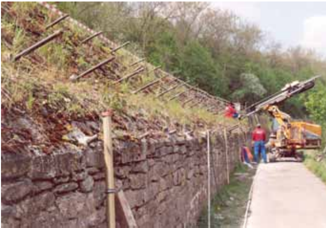
Confortement de mur de soutènement le long de la ligne de chemin de fer Limberg - Aumenu
