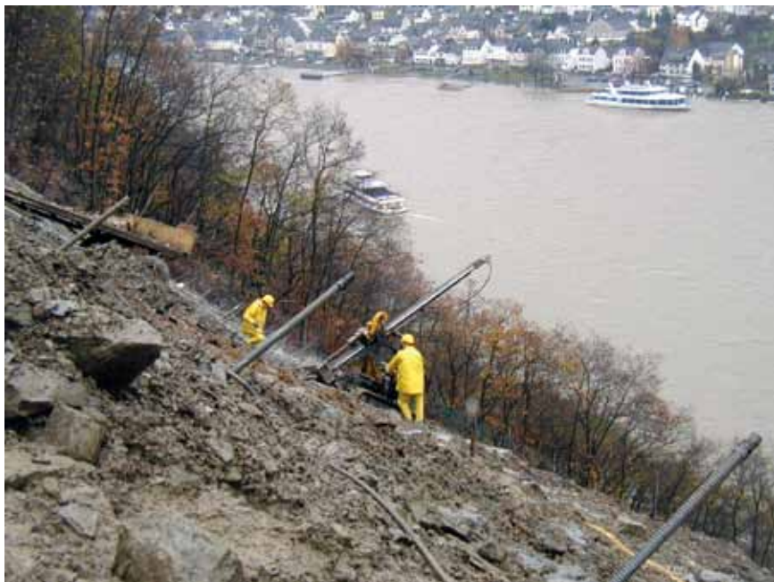
Confortement d'un talus sur les berges du Rhin, Bad Salzig
