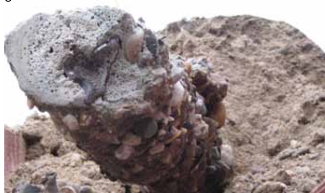
Corpo d'iniezione DRILL DRAIN® escavato
